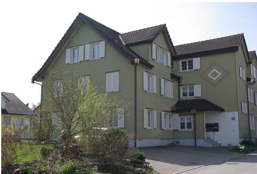
Das ehemalige Restaurant Rössli heute. Quelle: Eigenes Foto.
