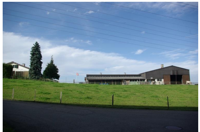
Der Aussiedlungshof Meggenhus
