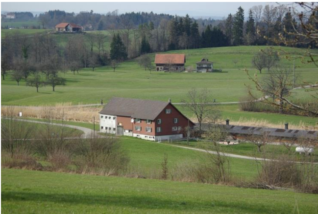
Das Schimishus vor der Renovation.
