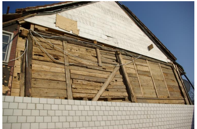
Die Holzkonstruktion des Stalltraktes während der Renovation.
