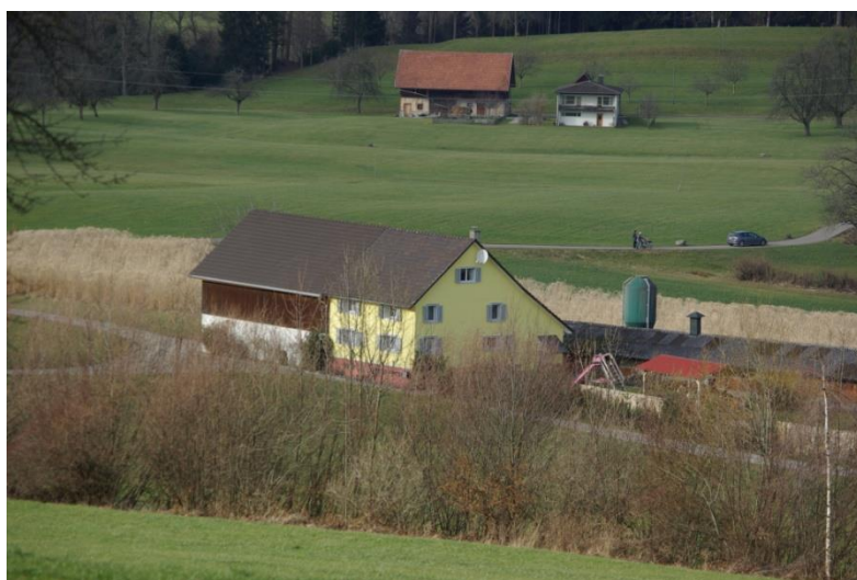
Schimishus nach der Renovation.
