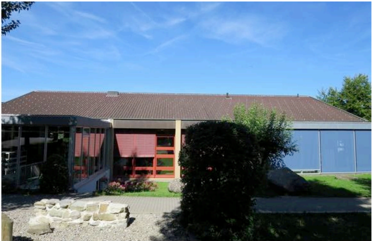
Auf dem Ost-Dach des Primarschulhauses Schachenmatten 2 entsteht die erste Fotovoltaikanlage des Vereins «solar-bonstetten». (Bild zvg.)
