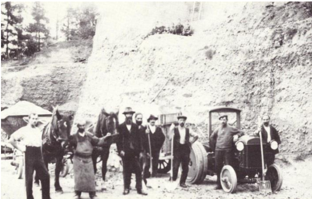
Die Kiesgrube im Filzhuet 1930.
