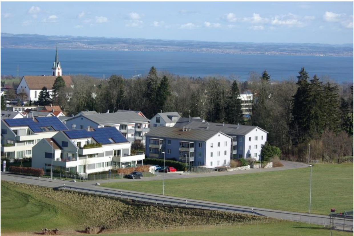
Die überbaute Bachwies zwischen St.Gallerstrasse und Häftlibach.
